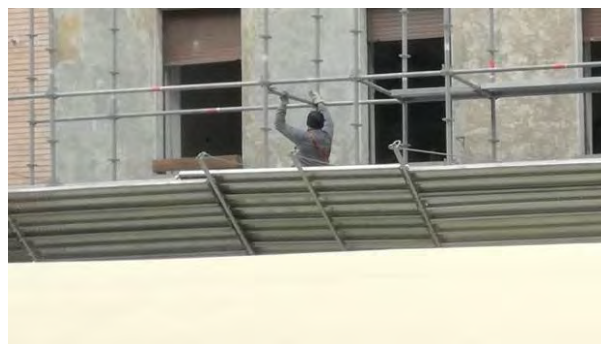
Figure 8.2 e 8.3: Un lavoratore impegnato nelle operazioni di montaggio di un ponteggio. Le ostruzioni del contesto impediscono al safety manager di valutare il corretto uso dei dispositivi anticaduta.
