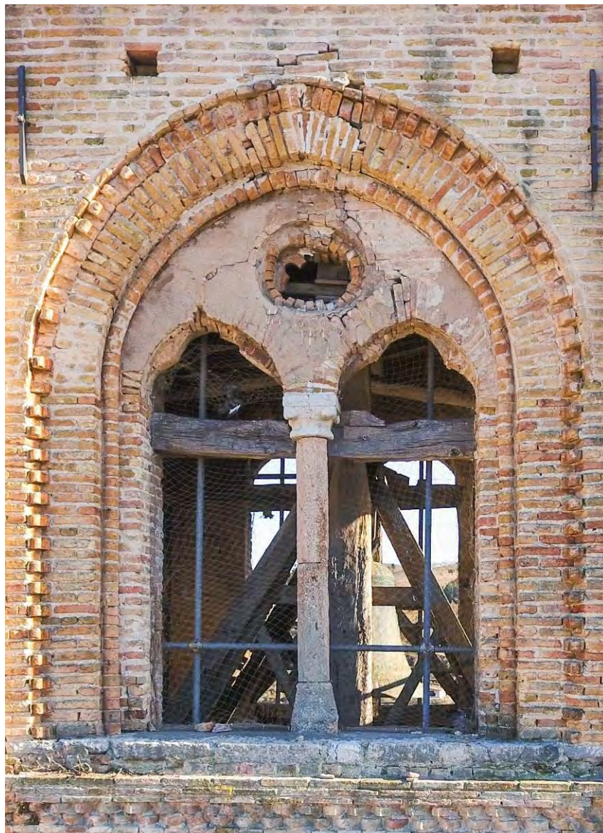
Figura 7.6: Foto da drone della bifora dissestata (ovest) del campanile del Duomo Vecchio di San Severino Marche.
