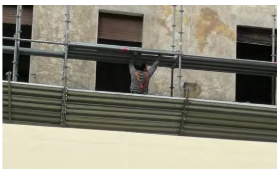
Figure 8.2 e 8.3: Un lavoratore impegnato nelle operazioni di montaggio di un ponteggio. Le ostruzioni del contesto impediscono al safety manager di valutare il corretto uso dei dispositivi anticaduta.
