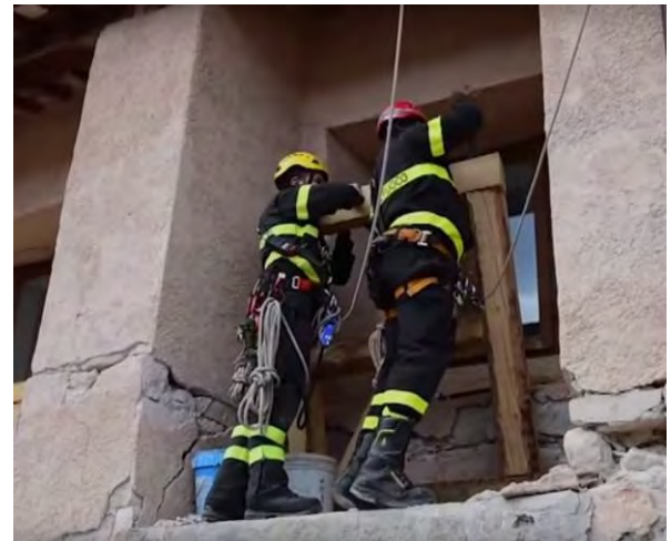
Figura 5.22: La sbadacchiatura viene regolata in quota con l'impiego di una sega a mano (Fonte: Canale Youtube VVF).
