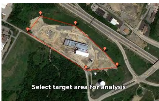
Figura 8.4: Viene selezionata l’area di cui si richiede l’analisi (Identified Technologies, 2016).
