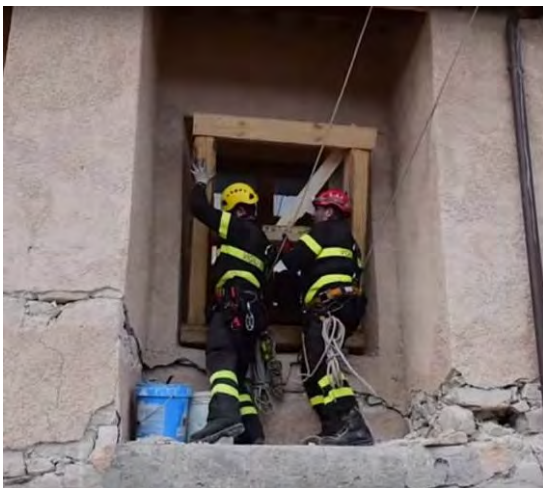
Figura 5.21: Posa in opera di sbadacchiatura preassemblata a terra (Fonte: Canale Youtube VVF).
