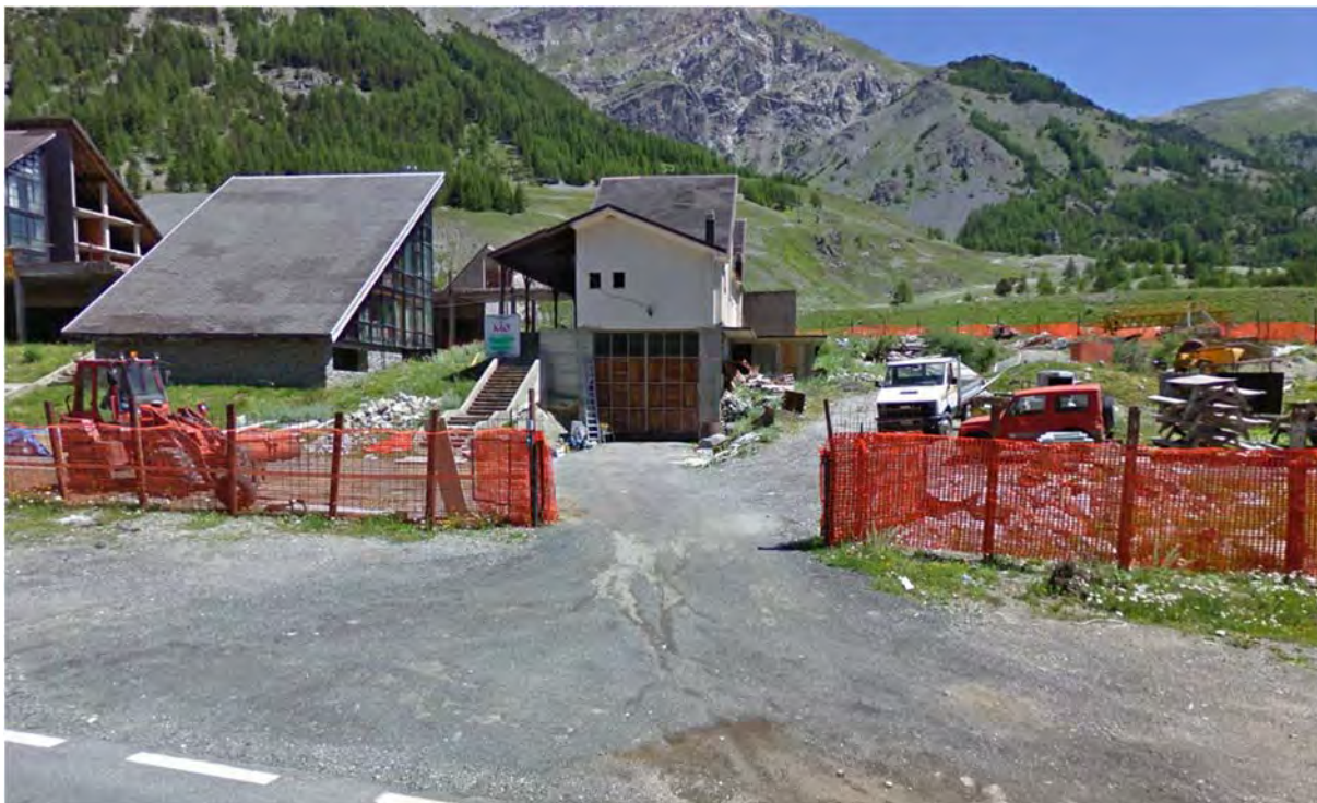
Figura 4.34: Accesso al cantiere.
