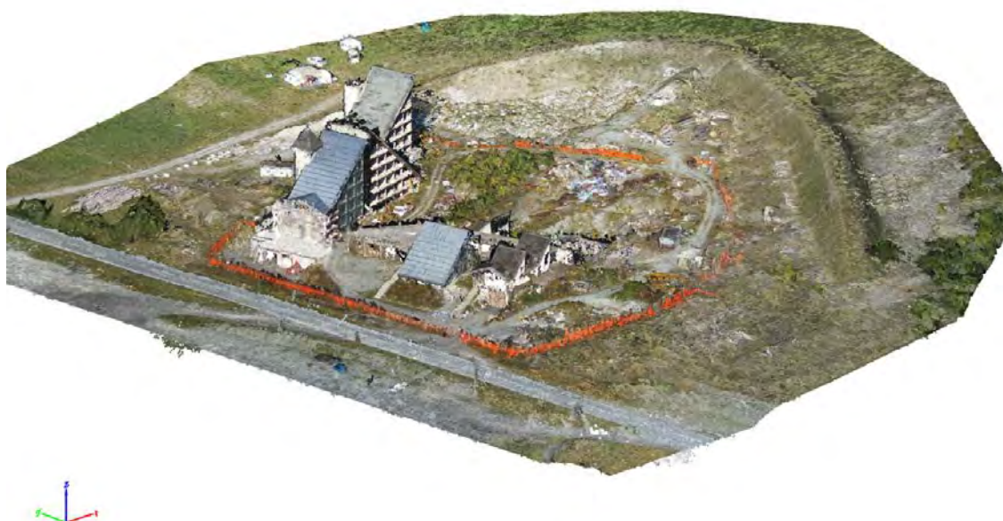
Figura 4.23: Dense cloud (nuvola densa) del cantiere.
