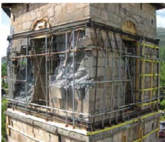
Figura 5.25: Particolare dell'intervento di sbadacchiatura delle aperture e di cerchiaggio della cella campanaria (Gruppo di Lavoro NCP, S. Grimaz coord., 2010).
