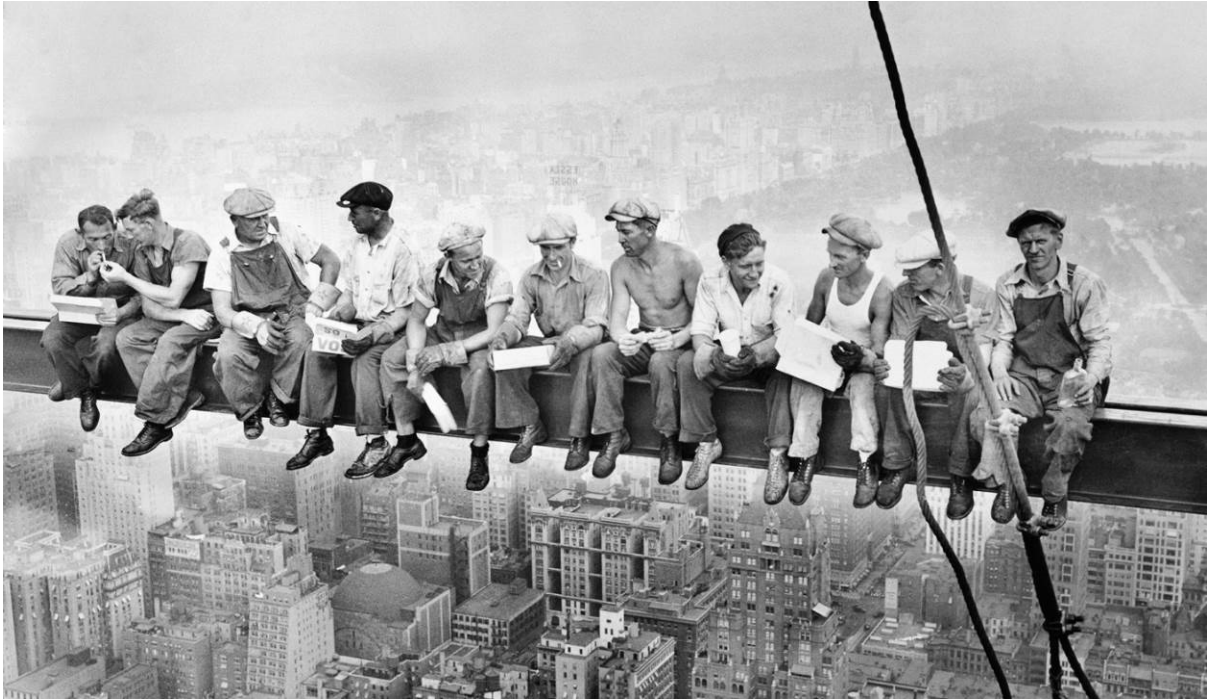
Figura 1.1: Lunch atop a Skyscraper (Fonte: Ebbets, 1932). La famosissima foto ritrae undici lavoratori seduti su una trave sospesa a 240 metri dal suolo. La foto è stata scattata a New York al sessantanovesimo piano del GE Building (ex RCA Building).
