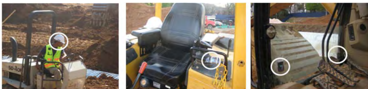
Figura 2.23: Posizionamento delle unità GPS su a) elmetto b) macchine di cantiere c) posizionamenti ridondanti su mezzi pesanti (Pradhananga & Teizer, 2012).
