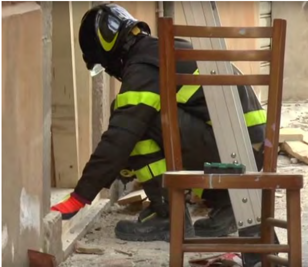
Figura 5.19: L'operatore misura la soglia di un'apertura avvalendosi di un metro a nastro (Fonte: Canale Youtube VVF).
