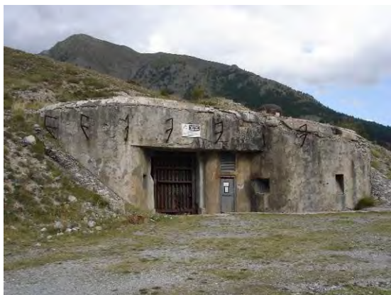
Figura 4.31: Fortino Sant’Orso (Ouvrage Saint Ours Haut) posto a difesa del passo della Maddalena (Col de Larche).
