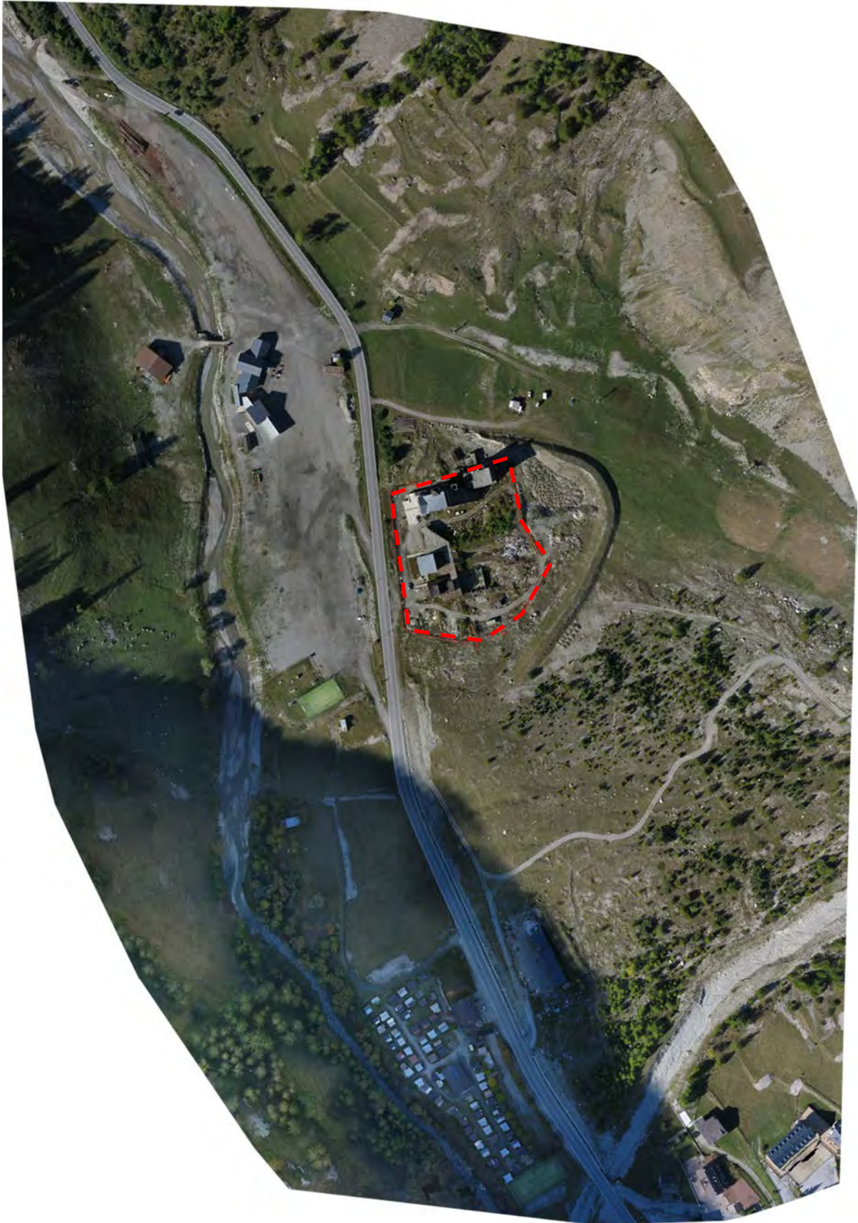
Figura 4.28: Ortofoto del contesto del cantiere (non in scala) generata da drone ad ala fissa eBee.
