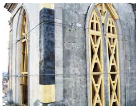
Figura 5.28: Sbadacchiatura delle bifore trilobate sovrapposte del campanile (Gruppo di Lavoro NCP, S. Grimaz coord., 2010).
