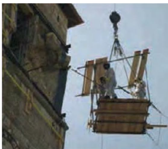
Figura 5.26: La piattaforma utilizzata per le operazioni di messa in sicurezza (Gruppo di Lavoro NCP, S. Grimaz coord., 2010).
