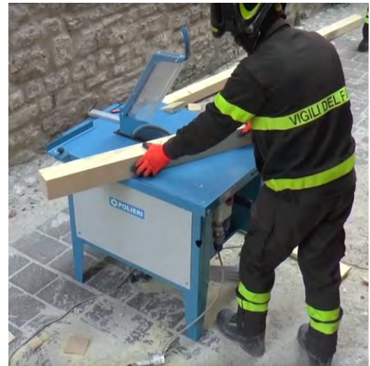
Figura 5.20: L'elemento ligneo della sbadacchiatura viene realizzato tramite sega da banco circolare (Fonte: Canale Youtube VVF).
