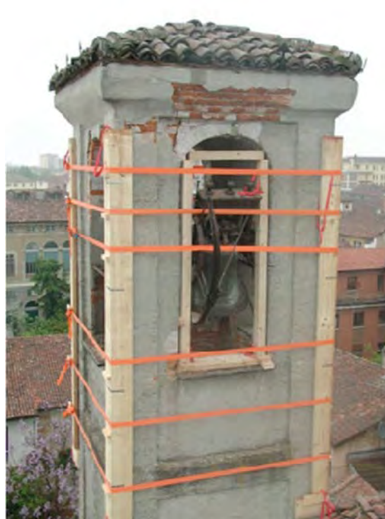
Figura 5.24: Cerchiatura della torre campanaria di Alessandria a seguito del terremoto del 2000 (Gruppo di Lavoro NCP, S. Grimaz coord., 2010).
